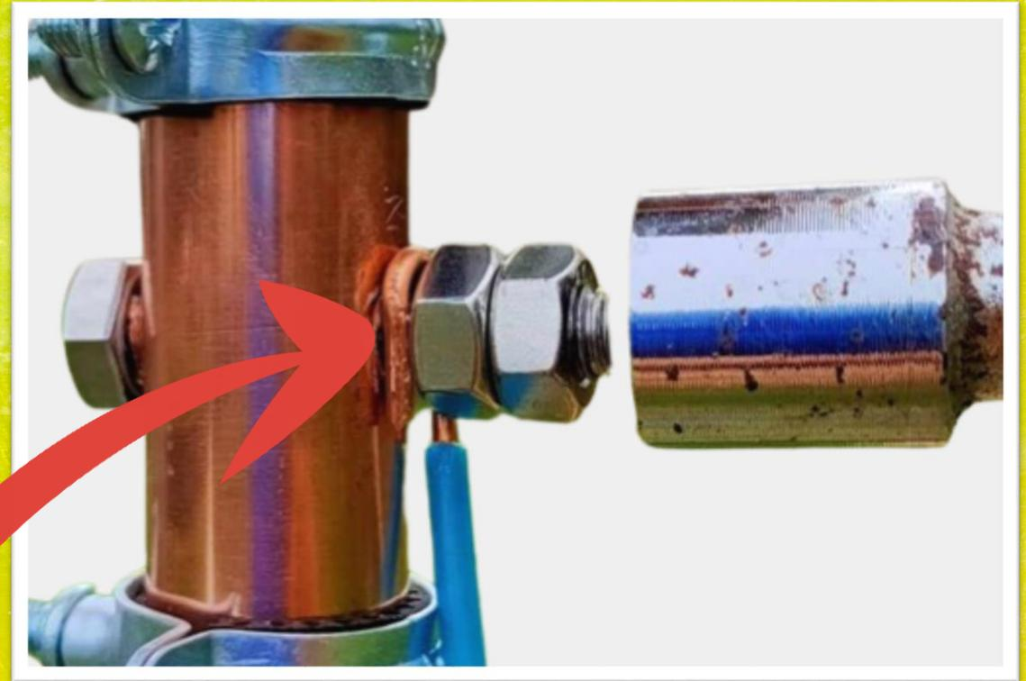
Le **câble cuivre**, qui connecte l'antenne au sol, doit avoir un bon contact électrique avec l'antenne.
